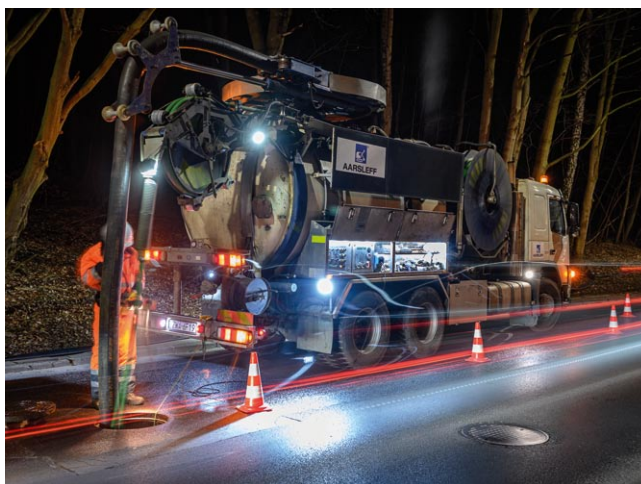
Bezwykopowe renowacje sieci wodociągowych i kanalizacyjnych
