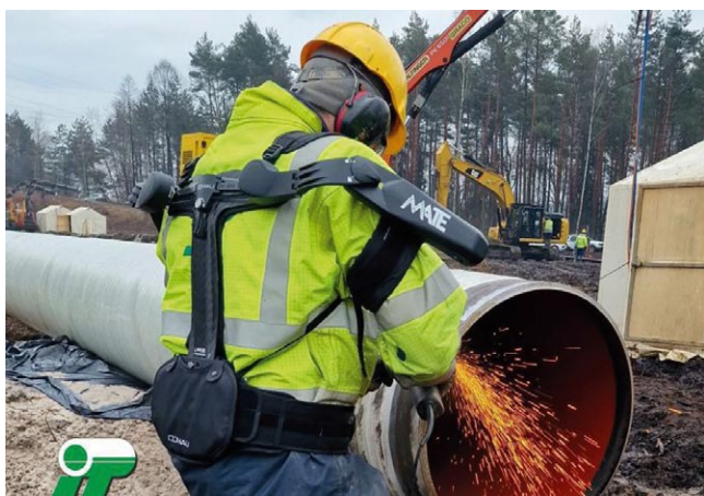
Rys. 1. Zdjęcie pracownika w egzoszkielecie na kontrakcie „Egzoszkielety „Human augmentation” realizowanym przez firmę JT S.A. [22]
