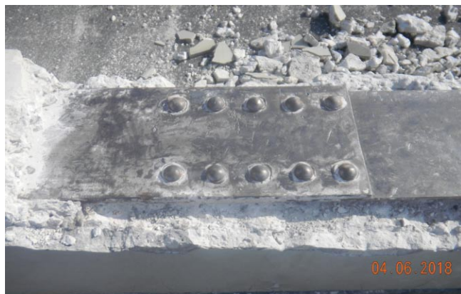
Rys. 9. Odkrywka połączenia montażowego na zakład pasów górnych ryglu i słupa z widocznym nitowaniem, potwierdzająca zgodność z projektem widocznym na rysunku 5
