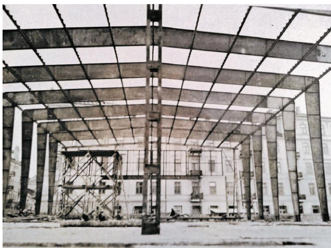
Rys. 2. Fotografie z realizacji budowy: widok zmontowanej konstrukcji ram stalowych od strony południowej (z lewej) i południowo-zachodniej (z prawej); od spodu widoczne rygle stalowe stropodachu [1]
