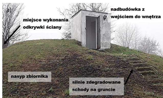
Rys. 3. Analizowany zbiornik: a) widok ogólny nasypu w wejściu do zbiornika, b) odkrywa ściany zbiornika
