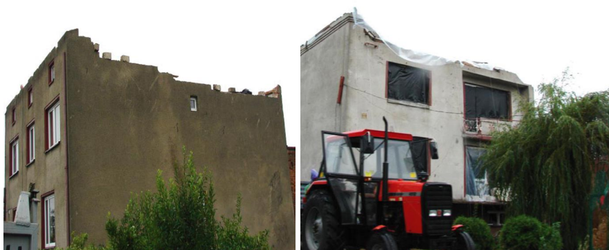
Rys. 1. Uszkodzenia powstałe na skutek działania silnych wiatrów
