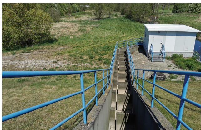
Rys. 4. Przeławka dla ryb przy małej elektrowni wodnej (archiwum własne)
