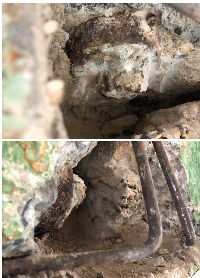
Rys. 3. Przykład żelbetowego bloku kotwiącego widocznego w odkrywcę
