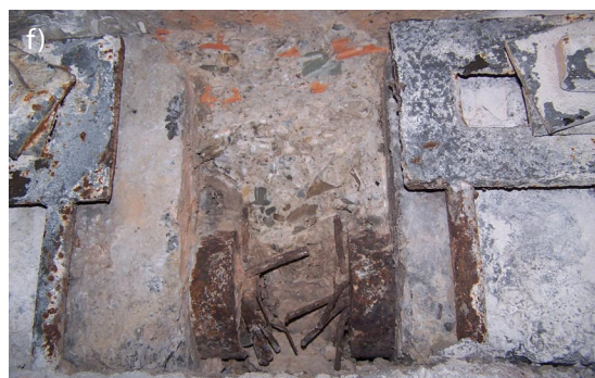
Rys. 5. Wybrane problemy w zakresie obetonowania bloków kotwiących: a) bardzo słaby beton, b, c) brak obetonowania, d) nasiąkliwy beton z kawałkami cegieł, e) szczelne obudowanie blachami, f) wspólne obetonowanie bloków kotwiących sąsiadujących dźwigarów
