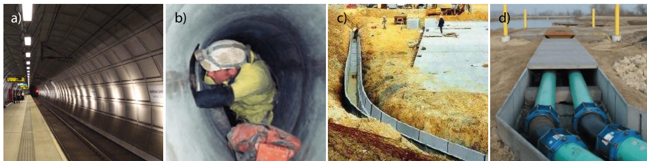
Rys. 5. Panele z GFRC dla tuneli [30] (a), panele z GFRC dla kanalizacji miejskiej [31] (b), panele z GFRC dla systemów melioracyjnych [32] (c), kanały z GFRC do ochrony rur elektrycznych [33] (d)
