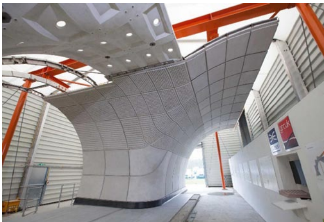
Rys. 7. Płyty z betonu zbrojonego włóknem szklanym [9]
