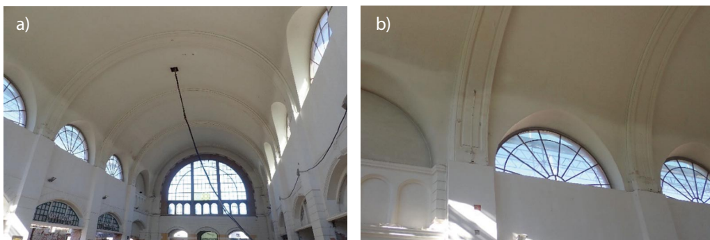
Rys. 4. Żelbetowe sklepienia kolebkowe (łupiny) nad Halą Główną Dworca Kolejowego Gdańsk Główny – widok: a) ogólny, b) w miejscu oparcia stalowych wiązarów konstrukcji dachu
