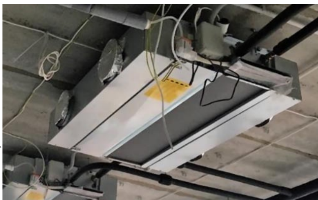
Rys. 8. Wentylokonwektor w systemie dwururowym
