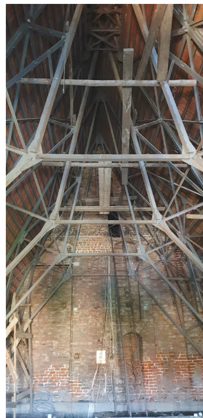
Rys. 5. Konstrukcja stalowa przekrycia nad prezbiterium w nawie środkowej kościoła pw. Świętych Apostołów Piotra i Pawła w Gdańsku
