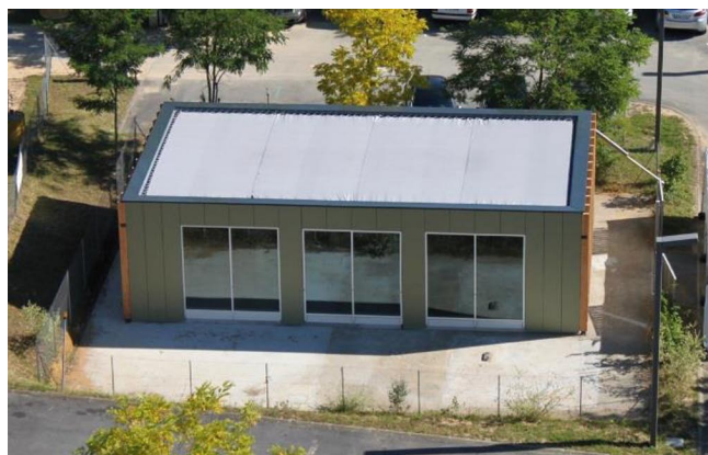
Rys. 1. Stanowisko badawcze do badań właściwości cieplnych fasad (Anglet, Francja)
