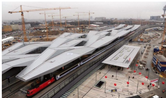
Rys. 2. Zadaszenie dworca głównego w Wiedniu [M6]
