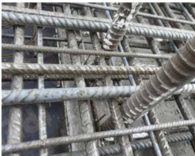
Rys. 2. Widok zbrojenia znajdującego się w osi słupów (fot. Fort Polska)
