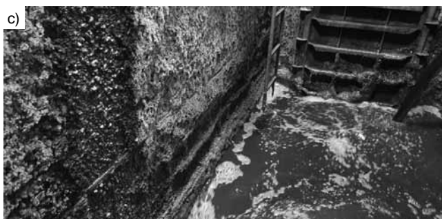
Rys. 3. Destrakcja komory rozdziału ścieków (obiekt nr 3) po około 10 latach użytkowania: a) wejście do komory – korozja betonu z odsłoniętym zbrojeniem, b) powierzchnia betonu pokryta produktami korozji, c) destrukcja ściany i widocznymi głębokimi wżerami w betonie w dolnej części i skorodowanym zbrojeniem
