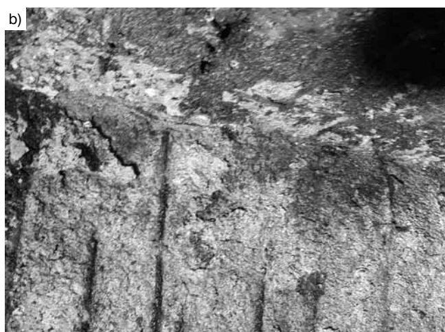
Rys. 3. Destrakcja komory rozdziału ścieków (obiekt nr 3) po około 10 latach użytkowania: a) wejście do komory – korozja betonu z odsłoniętym zbrojeniem, b) powierzchnia betonu pokryta produktami korozji, c) destrukcja ściany i widocznymi głębokimi wżerami w betonie w dolnej części i skorodowanym zbrojeniem
