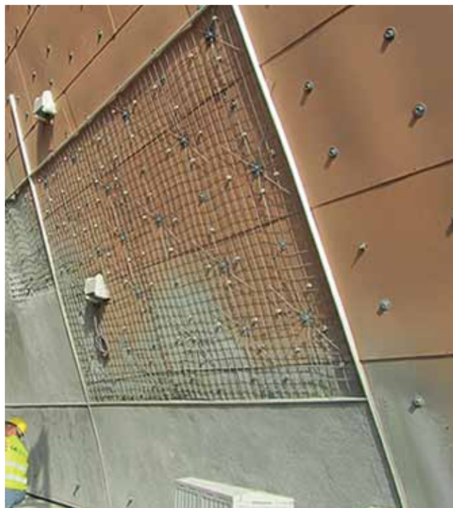
Rys. 7. Etapy wykonywania powłoki krzywoliniowej
