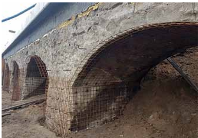
Rys. 2. Fragment estakady po oczyszczeniu z siatkami przeciwskurczowymi
