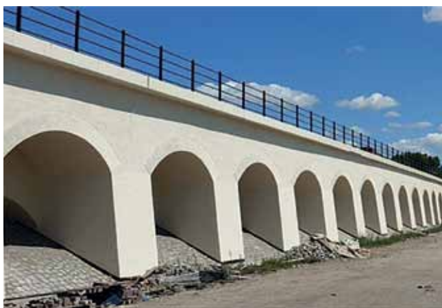
Rys. 4. Naprawiony obiekt w oryginalnym kolorze ecru
