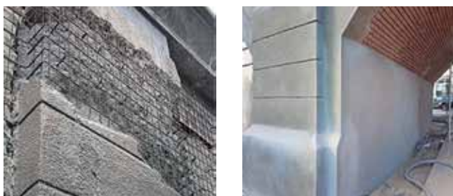
Rys. 3. Fragmenty boniowania przed naprawą i po niej
