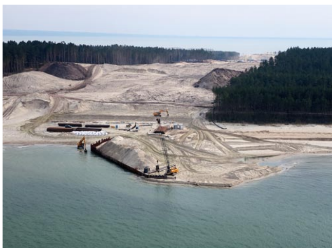
Rys. 3. Budowa nabrzeża południowego; stan obecny realizacji – kwiecień 2020
