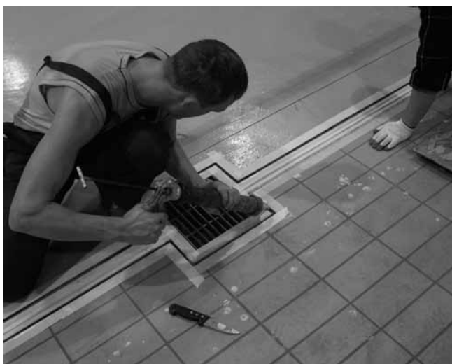
Rys. 7. Wypełnianie szczelin dylatacyjnych poliuretanową masą elastyczną
