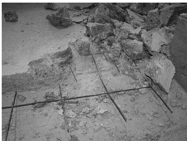
Rys. 2. Siatka zbrojeniowa ułożona bezpośrednio na podłożu
