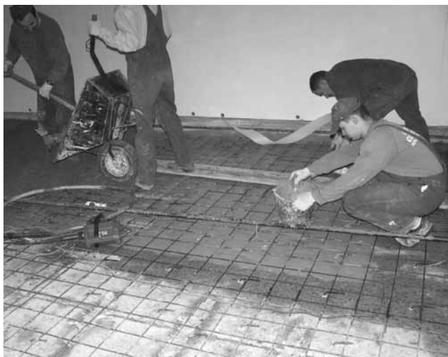
Rys. 5. Układanie mieszanki betonowej na świeżą warstwę mostkującą
