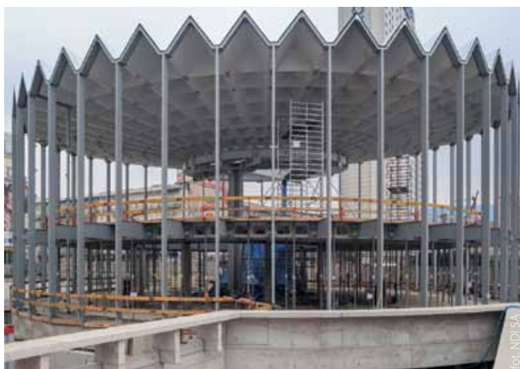
Rys. 1. Konstrukcja stalowa Rotundy wytworzona w Hucie Pokój SA
