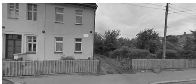
Rys. 1. Droga wzdłuż ściany północnej badanego budynku; po prawej ogródki z niską roślinnością
