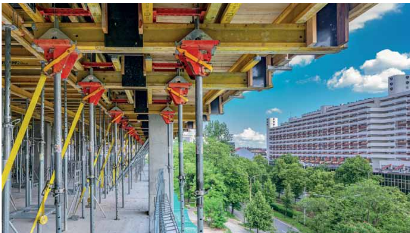
Rys. 4. Krawędziowe stoły stropowe PERI
