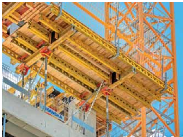
Rys. 5. Krawędziowy stół narożny PERI
