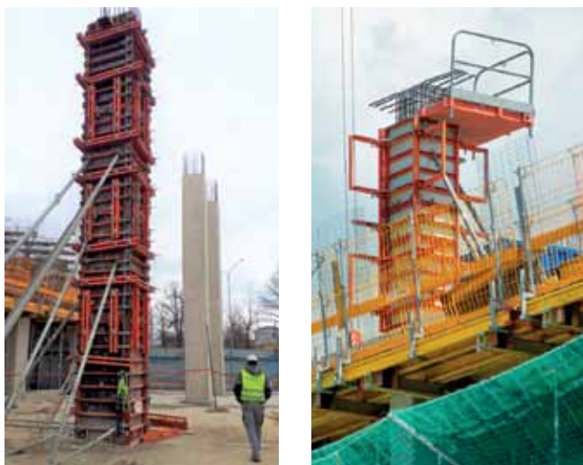
Rys. 6 i 7. Słupy wysokości ponad 11 m w deskowaniu TRIO oraz system PERI QUATTRO
