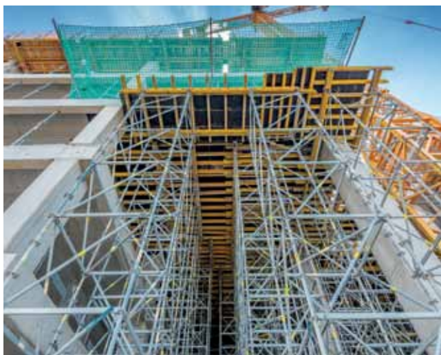
Rys. 8. Wysokie stropy łącznika w systemie PERI UP FLEX
