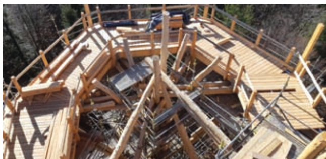
Rys. 6. Widok narożnika wieży widokowej w Krynicy Zdroju w trakcie budowy [5]
