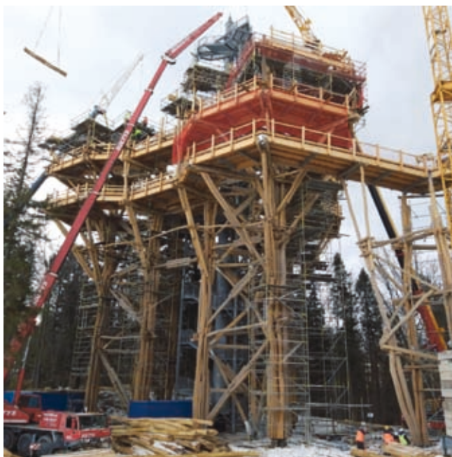
Rys. 5. Widok ogólny wieży widokowej w Krynicy Zdroju w trakcie jej budowy [5]
