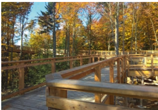
Rys. 3. Widok ogólny ścieżki napowietrznej, barier ochronnych i pochylni w trakcie budowy [5]
