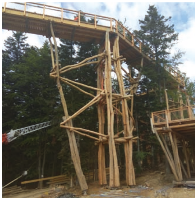
Rys. 4. Widok ogólny wieży wsporczej ścieżki napowietrznej w trakcie budowy [5]
