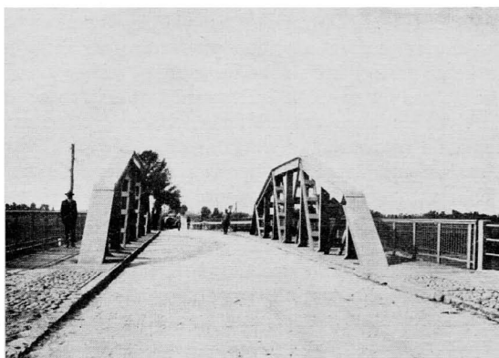
Fig. 18. Most na Słudwi pod Łowiczem, widok wewnętrzny.
