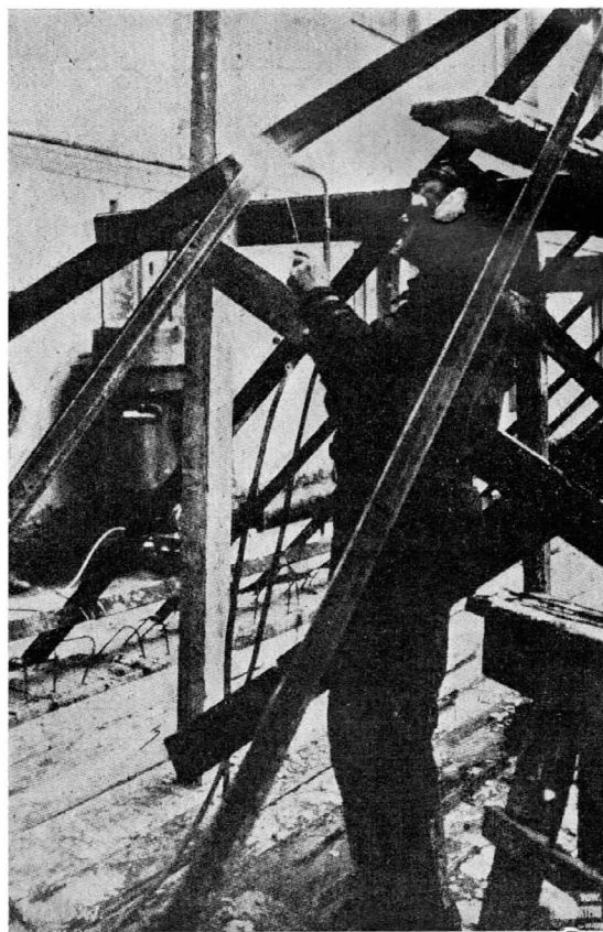
Fig. 2, 3. Łączenie poszczególnych części świetlika na miejscu budowy za pomocą spawania acetylenowego. W głębi widać wytwornicę acetylenu.
