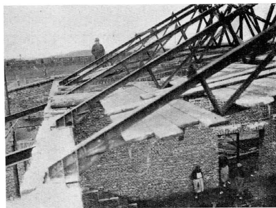
Fig. 4. Podporowe części więźarów dachu w Skarżysku.
