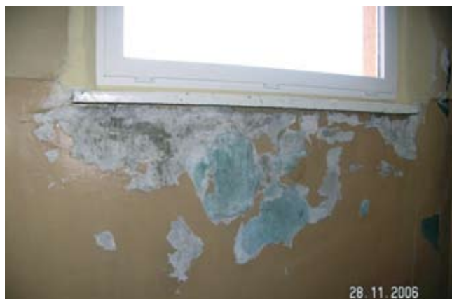
Rys. 5a. Złuszczenia farby i zawilgocenia tynku ściany w obrębie parapetu w budynku po wadliwym dociepleniu ścian zewnętrznych
