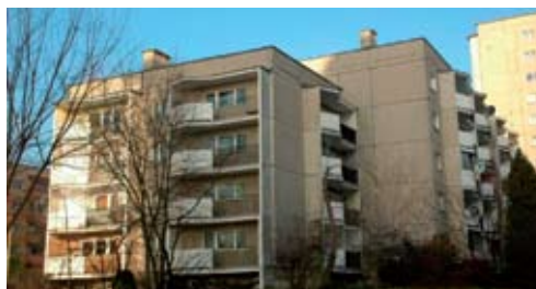
Rys. 9. Budynek segmentowo-klatkowy – stan obecny (fot. archiwum zespołu)
