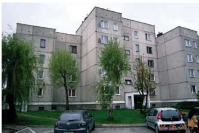
Rys. 2a. Budynek nr 1 – widok od strony północno-wschodniej
