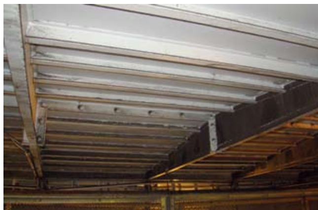
Rys. 4. Widok od wewnątrz na dach galerii transportowej
