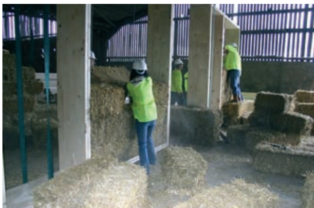
Fot. 1. Wypełnianie prefabrykowanych paneli ModCell balotami słomy [4]
