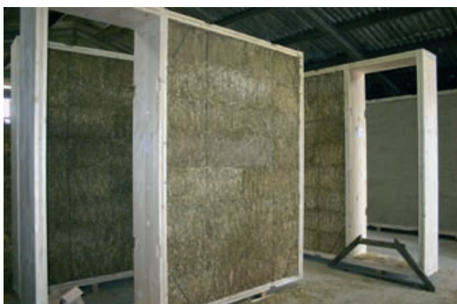
Fot. 2. Prefabrykowane panele ModCell wypełnione balotami słomy [4]
