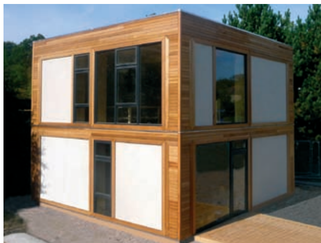
Fot. 6. Eksperymentalny budynek BaleHaus na kampusie uniwersyteckim w Bath [4]
