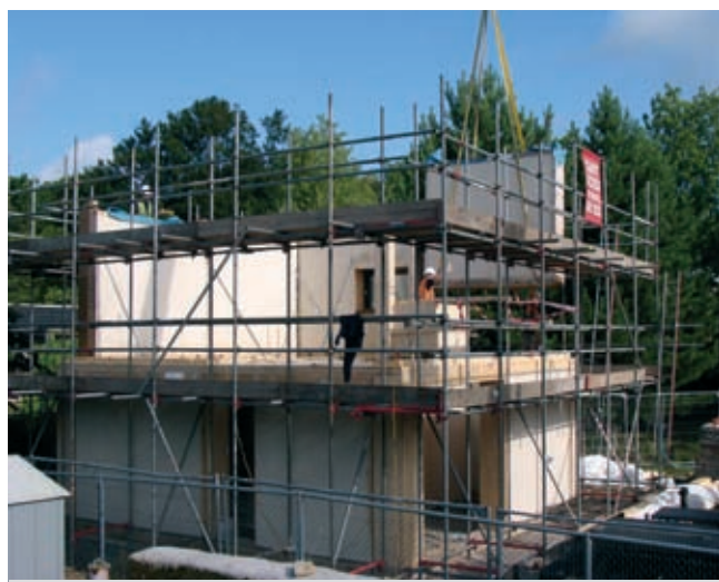
Fot. 3. Montaż prefabrykowanych paneli na budowie [5]
