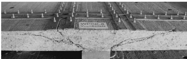
Rys. 10. Przekrój przez model WPSK-8 po zniszczeniu
