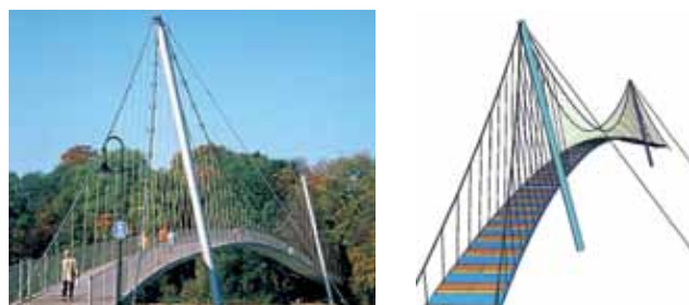
Rys. 3. Kładka wisząca w Minden zaprojektowana przez SBP Stuttgart; widok na podporę i belkowy model numeryczny MES SOFiSTiK
