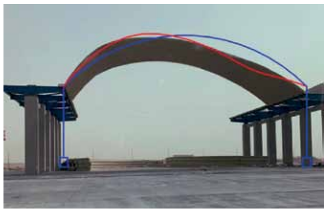
Rys. 8. Deformacja konstrukcji od obciążenia wiatrem nałożona na obraz deformacji konstrukcji
