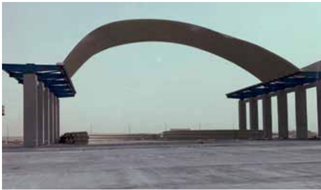
Rys. 2. Deformacja łukowego przekrycia ABM240 spowodowana oddziaływaniem wiatru
