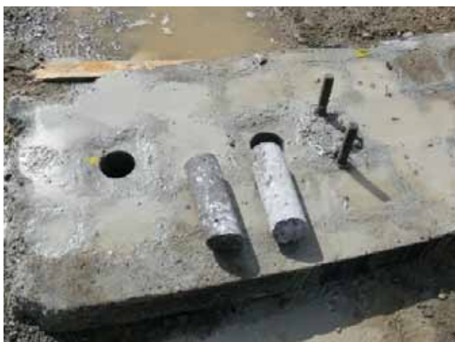
Rys. 10. Widok rdzeni betonowych pobranych z fundamentu
