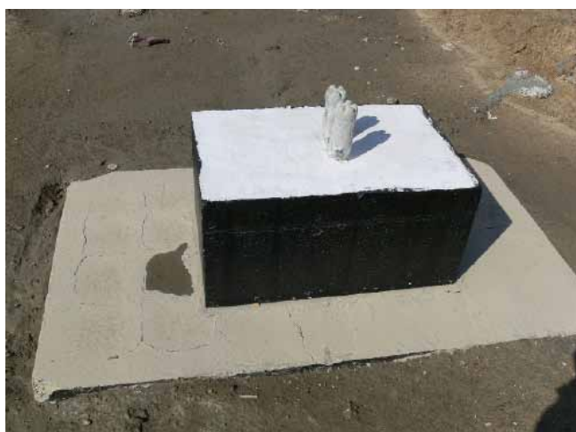
Rys. 4. Rysy widoczne poprzez warstwę mineralnego zabezpieczenia powierzchniowego na odsadźce fundamentu betonowego
