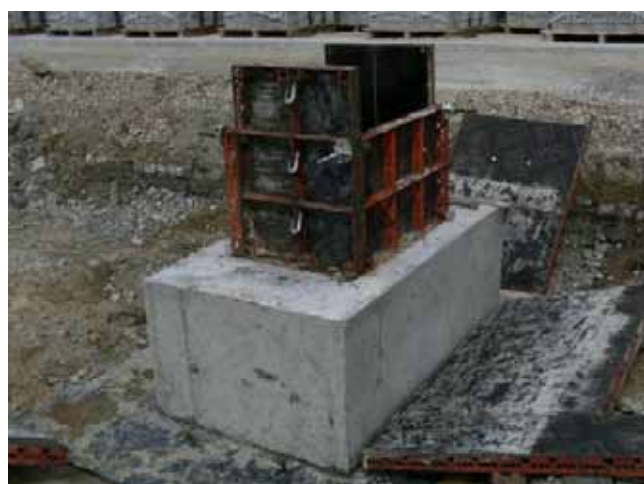
Rys. 8. Częściowo rozszalowany fundament betonowy, pozostawiony bez dalszej pielęgnacji
