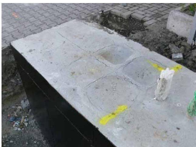
Rys. 1. Widok fundamentu z wyraźnymi rysami na powierzchni górnej
