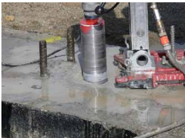
Rys. 9. Wykonywanie odwiertu w fundamencie betonowym w celu pobrania próbek do badań wytrzymałości na ściskanie
