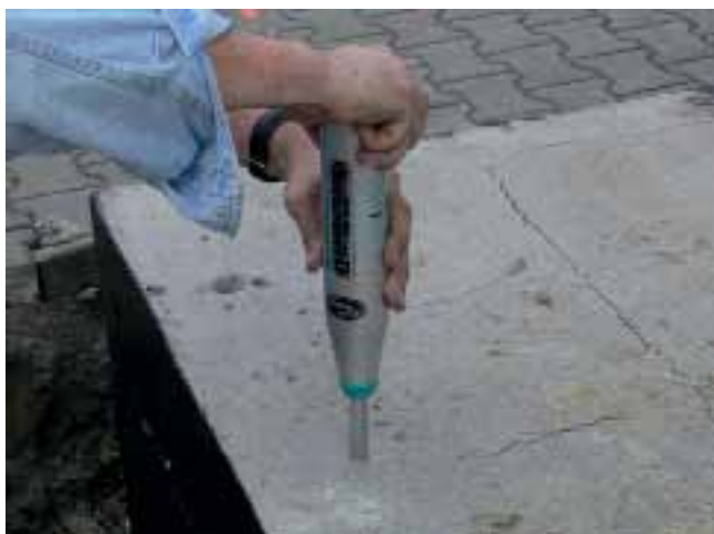
Rys. 13. Badanie nieniszczące młotkiem Schmidta – pomiar liczby odbicia na powierzchni fundamentu betonowego
