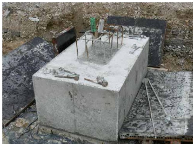
Rys. 7. Fundament betonowy po rozszalowaniu pozostawiony bez dalszej pielęgnacji
