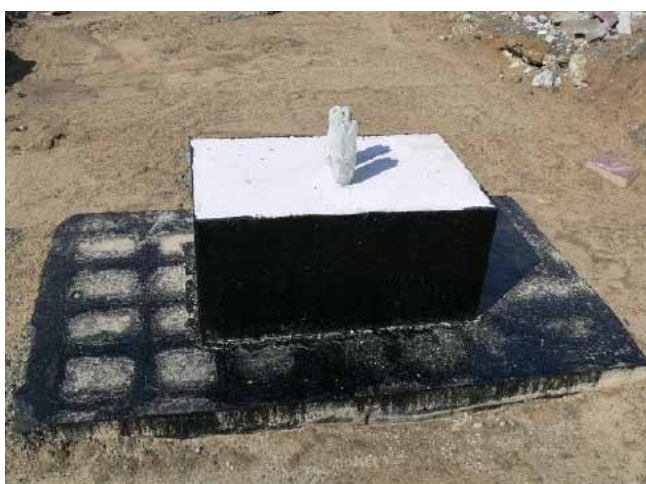
Rys. 6. Rysunek spękań fundamentu betonowego przykryty warstwą bitumicznego zabezpieczenia powierzchniowego
