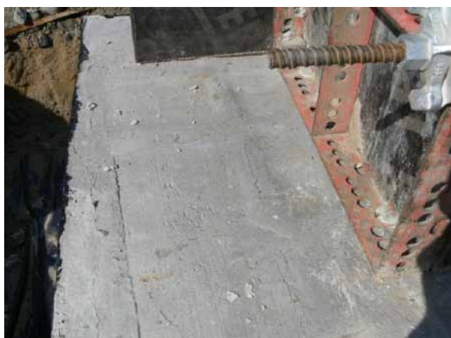
Rys. 3. Widoczne rysy na powierzchni odsadzki fundamentu betonowego
