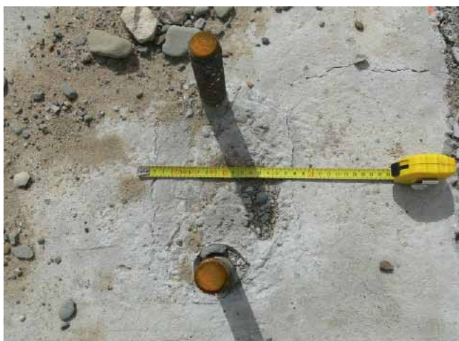
Rys. 5. Widoczne rysy na powierzchni fundamentu betonowego w okolicy kotew stalowych
