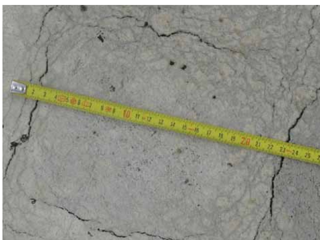
Rys. 2. Rysy i spękania na powierzchni górnej fundamentu betonowego
