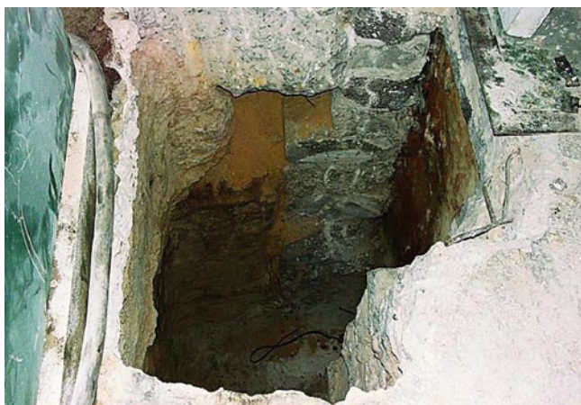
Rys. 3. Odkrywka płyty wielkich sił od strony planowanej styku
