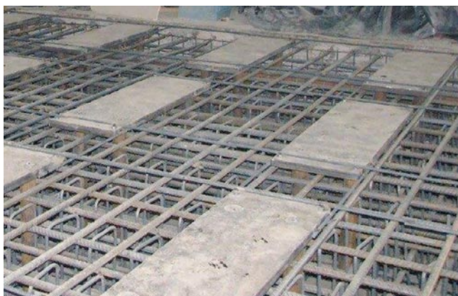
Rys. 6. Widok zbrojenia płyty
