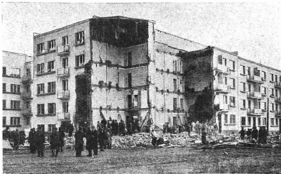
Rys. 3. Widok ściany A B D E.
