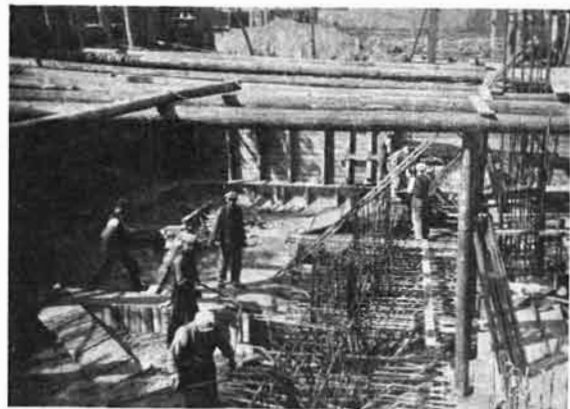
Betonowanie płyty fundamentowej.
