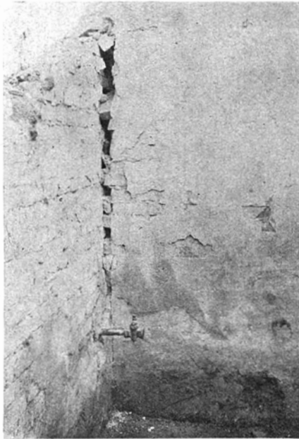
Rys. 2. Widok gazociągu ulicznego w narożu „A”.
