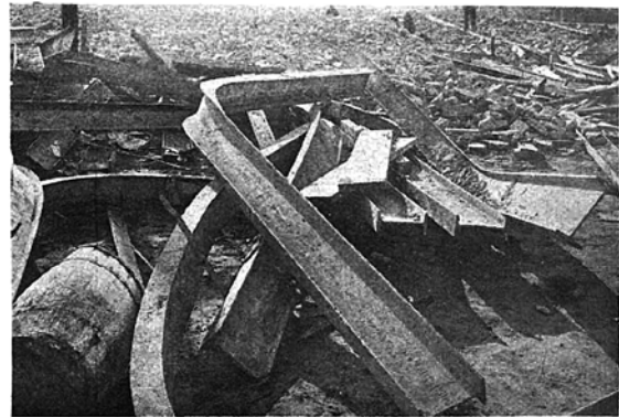
Rys. 8. Złożone na placu belki stropu nadpiwnicznego.
