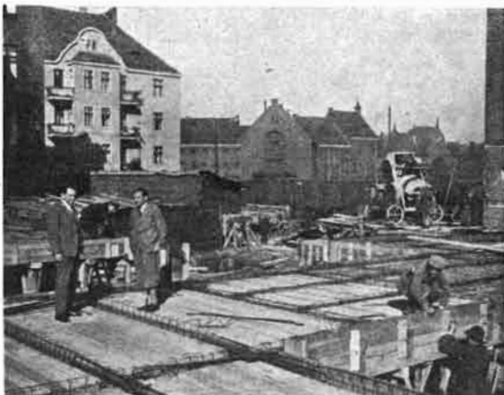
Zbrojenie stropu suterren górnych.
