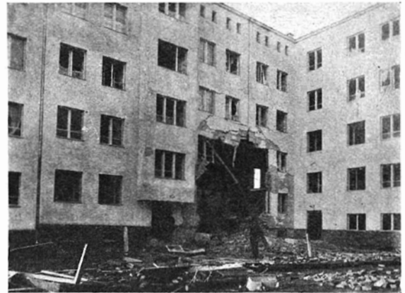
Rys. 5. Widok ściany F G.
