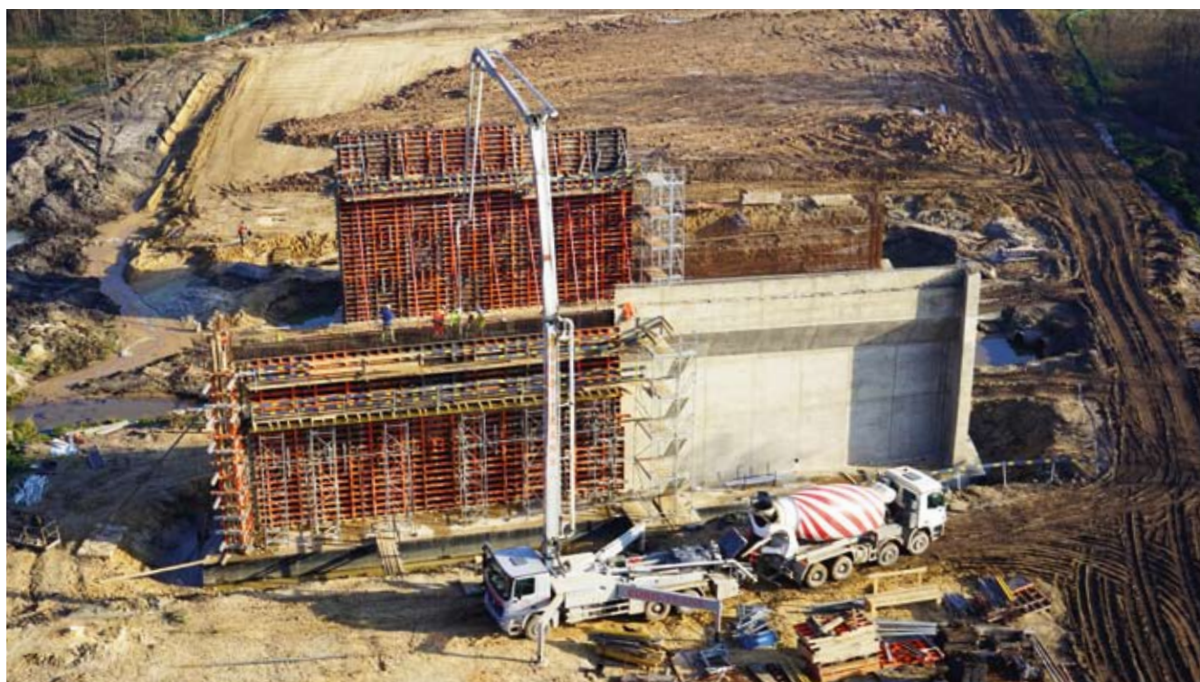
Rys. 1. 12-metrowe ściany przyczółków
