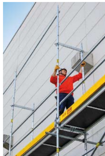
Rys. 3. Montaż zintegrowanej poręczy głównej wyprzedzającej
