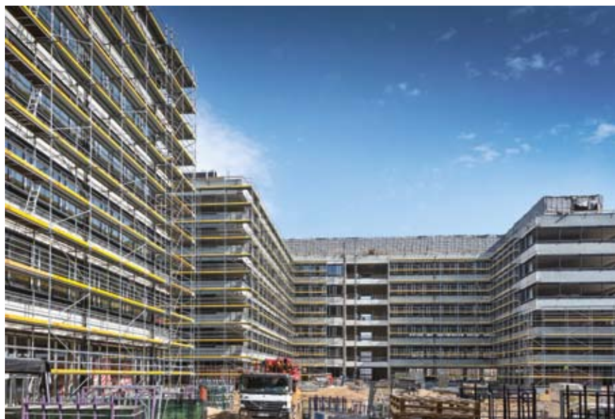
Rys. 1. Nowy system rusztowania ramowego firmy PERI – PERI UP Easy na budowie II etapu kompleksu Business Garden Poznań
