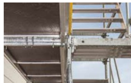
Rys. 6. Przejście między schodami dołączonego bezpośrednio do ramy Easy zewnętrznego pionu komunikacyjnego a głównym polem rusztowania
