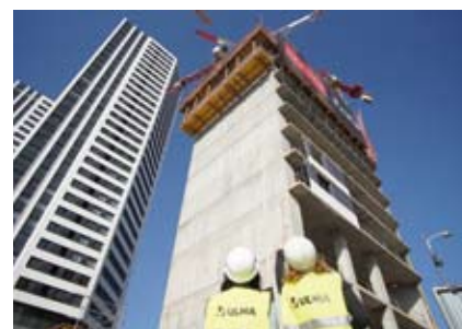
System RKS na budowie wieżowca Garellano w Bilbao
