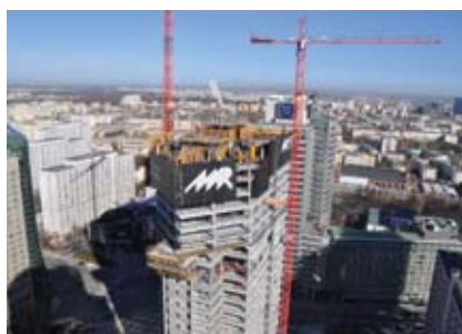
System ATR podczas budowy wieżowca Q22 w Warszawie
