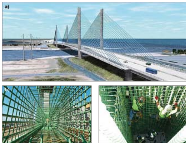
Rys. 7. Most na wlocie rzeki Indian w Sussex County, stan Delaware (USA): a) widok całego mostu, b) szkielet zbrojeniowy zabezpieczony powłoką epoksydową, c) zbrojenie z powłoką w trakcie montażu; [M2]
