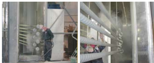
Rys. 1. Nakładanie powłok epoksydowych na stal zbrojeniową [M1]
