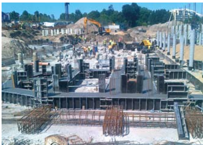
Rys. 4. Wykonywanie oczepów fundamentowych
