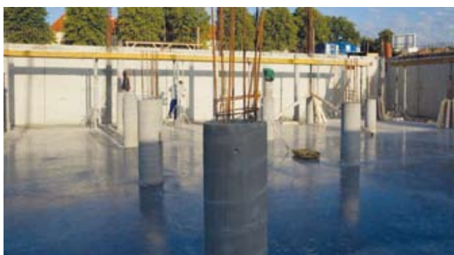
Rys. 5 i 6. Betonowanie dna niecki sportowej – technologia Leier-Panel
