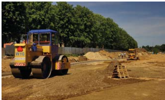
Rys. 3. Budowa układu drogowego
