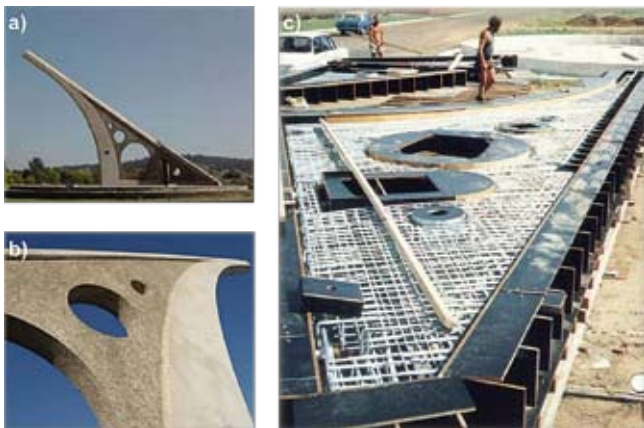
Rys. 10. Największy na świecie zegar słoneczny – Australia: a) widok całej konstrukcji, b) widok z dołu, c) ocynkowane zbrojenie w deskowaniu; [M4]
