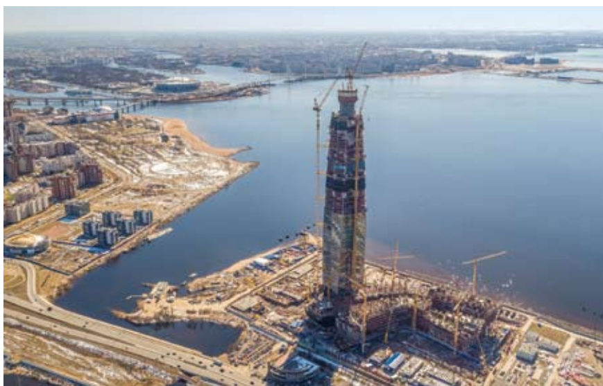
Rys. 2. Unikalne położenie u brzegu Morza Bałtyckiego w Zatoce Fińskiej było wielkim wyzwaniem. Posadowienie budynku wysokościowego było skomplikowane nie tylko z powodu jego wysokości i dużego obciążenia wiatrem, lecz również ze względu na wyjątkową geologię terenu (fot. PERI GmbH)
