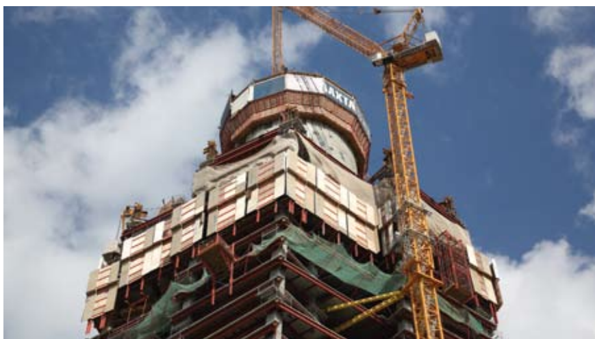
Rys. 4. Osłony zabezpieczające RCS-P okalają szczelnie budynek, chroniąc załogę budowy na trzech kondygnacjach przed upadkiem z wysokości i szalejącym wiatrem. Przegubowe uchwyty stropowe oraz teleskopowe osłony pozwalały na bezpieczne mocowanie do stropów i zachowanie szczelności pomimo ciągłych zwężeń i uskoków oraz umożliwiały samoczynne wspinanie osłon po spiralnej geometrii budynku (fot. PERI GmbH)
