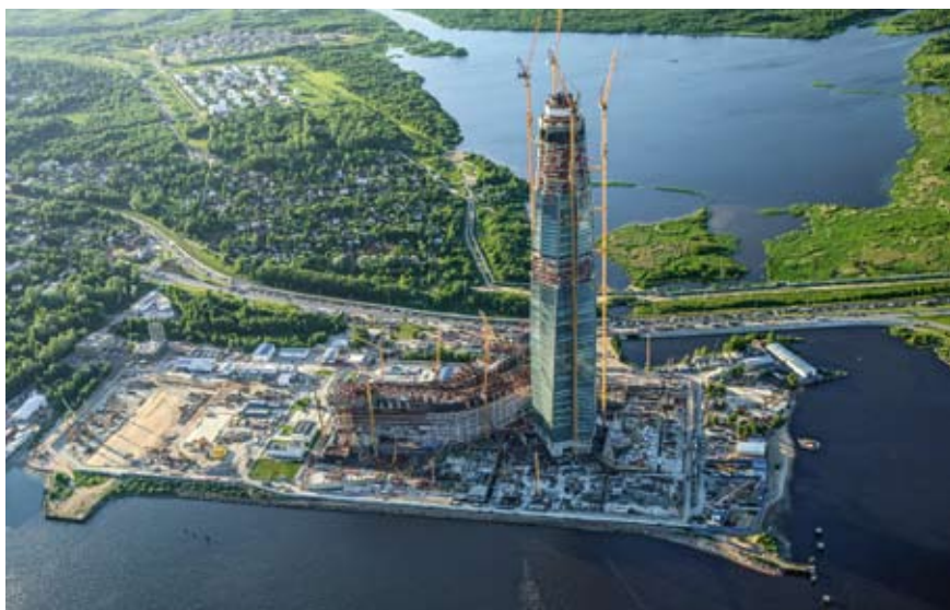
Rys. 1. W Sankt Petersburgu powstaje najwyższy wieżowiec w Europie. Siedziba koncernu energetycznego Gazprom Neft będzie mierzyć 462 m. W skład przedsięwzięcia wchodzi ponadto spektakularny budynek wielofunkcyjny, amfiteatr i rozległe parki (fot. PERI GmbH)
