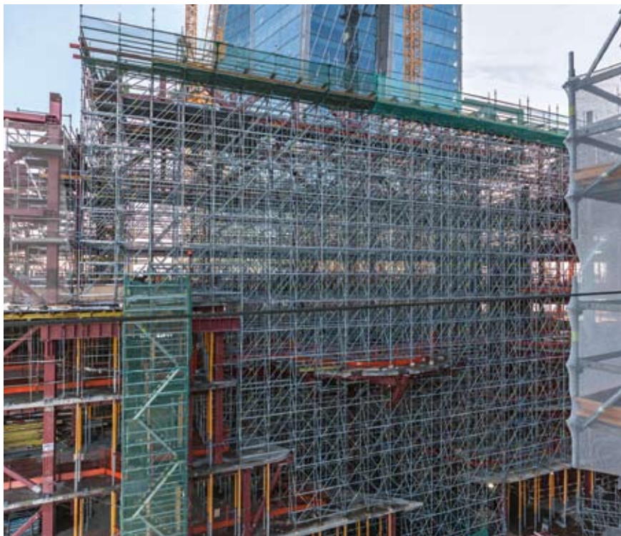
Rys. 7. Dostawy PERI obejmowały również najróżniejsze rusztowania podporowe w budynku wielofunkcyjnym. Za pomocą rusztowania modułowego PERI UP Flex można było efektywnie przenosić duże obciążenia z dużych wysokości (fot. PERI GmbH)
