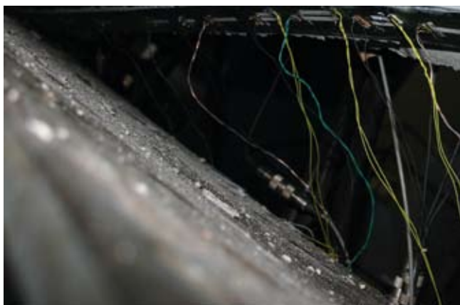
Rys. 3. Odspojenie taśmy CFRP po zniszczeniu
