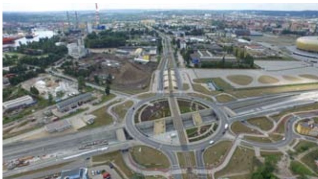
Budowa węzła Marynarki Polskiej
