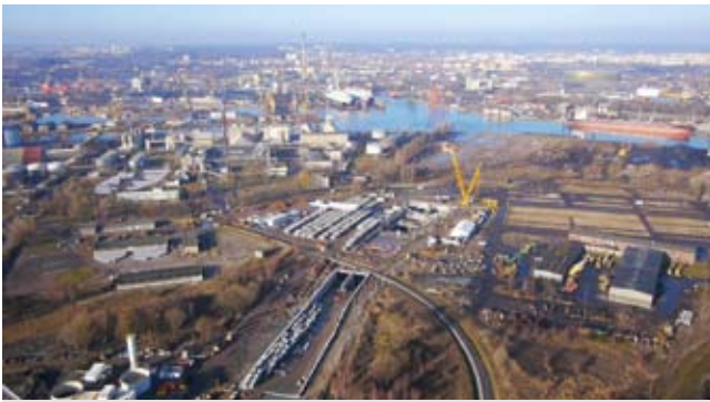
Budowa tunelu od strony węzła Ku Ujściu
