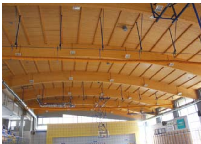
Rys. 2. Widok dźwigarów (archiwum autora) ...
