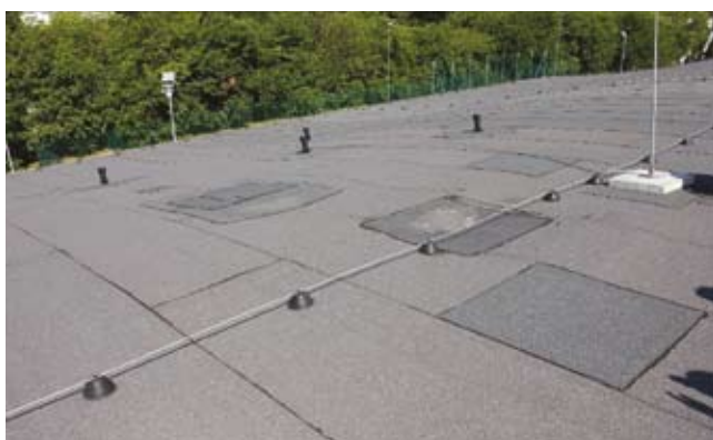
Rys. 3. Pokrycie dachu wielokrotnie naprawiane (archiwum autora)
