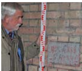
Rys. 10. Pomiary wysokościowe osadzenia tablicy dotyczącej powodzi z 1888 roku pod wiaduktem na końcu ul. Ku Cytadeli (fot. Z. Walczak)
