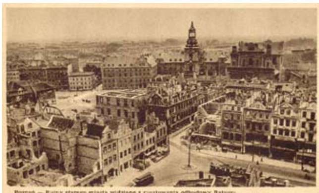
Rys. 3. Ruiny Starego Rynku, w tym pierzei wschodniej, widziane z rusztowania odbudowywanej wieży ratusza, wg. fot. R.S. Ulatowskiego (ok. 1950 r.) [w zbiorach autora; wyd. Wielkopolski Instytut Wydawniczy, ok. 1950; b.o.p.]
