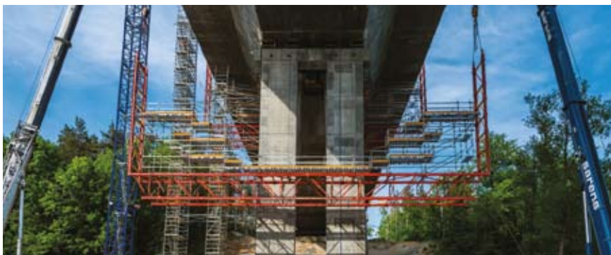
Rys. 4. Podnoszenie pomostu wózka wraz z wieszakami
