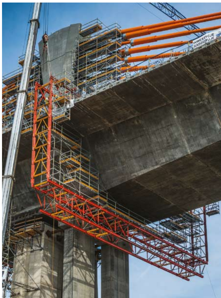
Rys. 1. Widok wózka w końcowej fazie montażu
