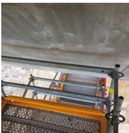
Rys. 3. Widok pomostu roboczego
