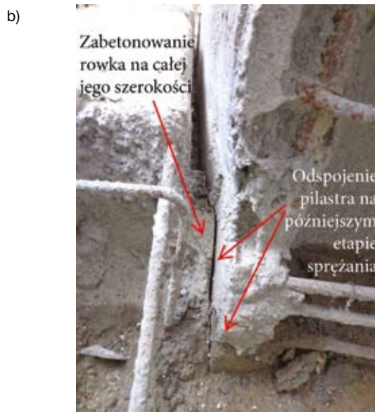
Rys. 6. Niewłaściwa realizacja kształtu ściany w obrębie rowka (a), zabetonowanie rowka na całej jego szerokości (b)
