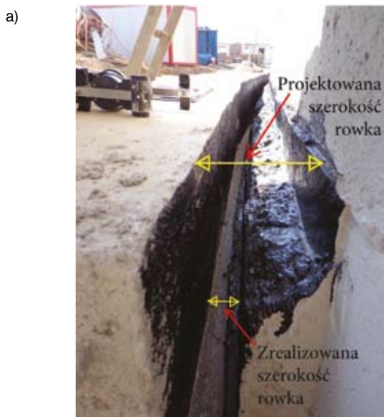
Rys. 6. Niewłaściwa realizacja kształtu ściany w obrębie rowka (a), zabetonowanie rowka na całej jego szerokości (b)
