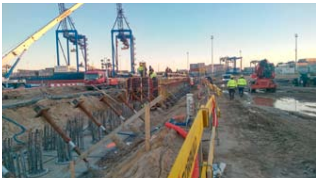
Rys. 8. Poddźwigowa belka odlądowa, roboty żelbetowe grudzień 2015 r. (fot. Łukasz Małkiewicz)
