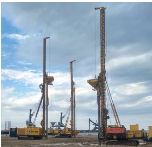
Rys. 11. Wzmocnienie podłoża gruntowego, lipiec 2015 r. (fot. Łukasz Małkiewicz)
