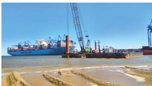
Rys. 7. Pograżanie pierwszego pala – pal testowy 17 lipca 2015 r. (fot. Łukasz Małkiewicz)
