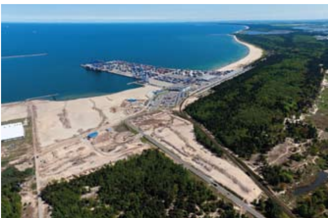
Rys. 3. Roboty ziemne terminal T2, maj 2015 r. (źródło: zasoby NDI SA)
