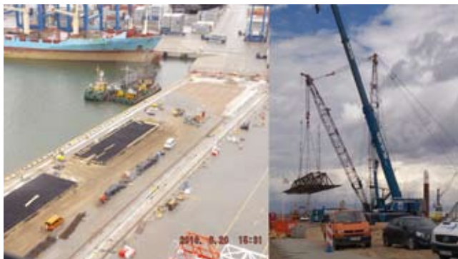
Rys. 10. Prefabrykacja materacy FOSA oraz dźwig pływający wraz z ramą umożliwiającą podłączenie materaca, czerwiec 2016 r. (fot. Łukasz Małkiewicz)
