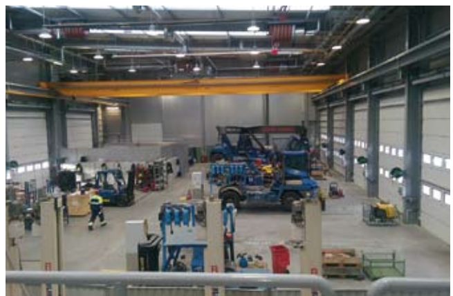
Rys. 4. Nowa hala warsztatowa, styczeń 2016 r. (autor: Łukasz Małkiewicz)
