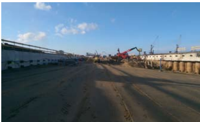
Rys. 9. Przygotowanie pod montaż dolnego rzędu ściągów marzec 2016 r. (fot. Łukasz Małkiewicz)
