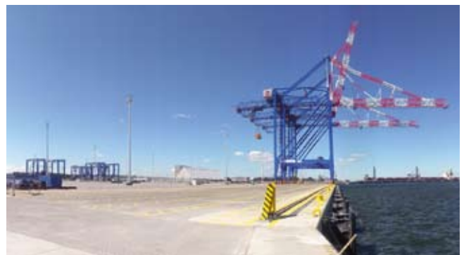
Rys. 14. Ukończony terminal, sierpień 2016 r. (fot. Łukasz Małkiewicz)
