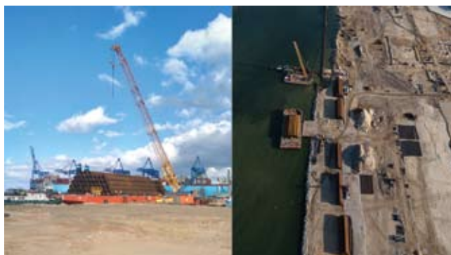
Rys. 6. Lewa strona: Tymczasowy Pirs Przeładunkowy widok od strony lądu (autor: Łukasz Małkiewicz), prawa strona: Tymczasowy Pirs Przeładunkowy oraz grobla kamienna widok z góry (fot. zasoby NDI SA)
