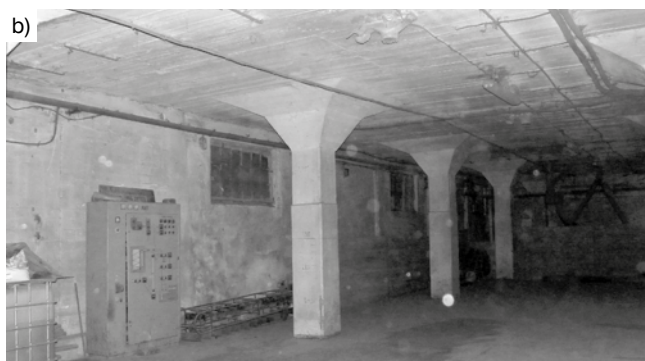
Rys. 8. Powojenne stropy grzybkowe, wprowadzone w wyniku adaptacji na magazyny zbożowe: a) bardziej krępe cementowni Silesia, b) smuklejsze we Wróblinie
