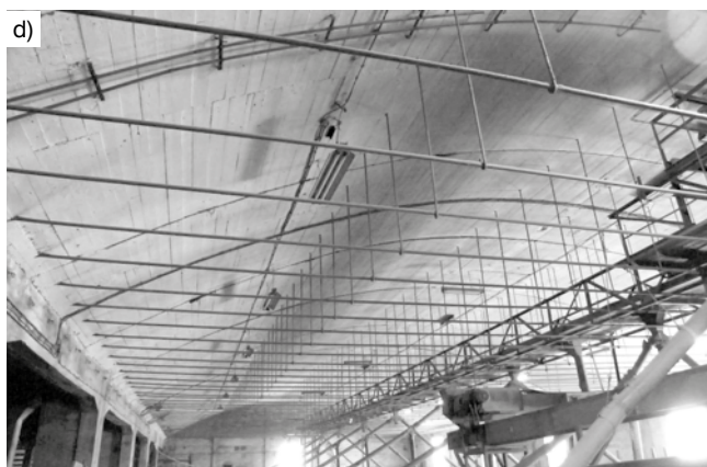
Rys. 7. Konstrukcja nawy: a) kratownicowa, stalowa cementowni Silesia (nawa główna), b) żelbetowa, łukowa z dachem dwuspadowym cementowni Wróblin (nawa główna), c) kratownicowa, stalowa cementowni Silesia (nawa boczna), d) żelbetowa łukowa z podwieszonymi ściągami cementowni Wróblin (nawa boczna)
