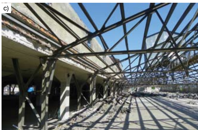
Rys. 7. Konstrukcja nawy: a) kratownicowa, stalowa cementowni Silesia (nawa główna), b) żelbetowa, łukowa z dachem dwuspadowym cementowni Wróblin (nawa główna), c) kratownicowa, stalowa cementowni Silesia (nawa boczna), d) żelbetowa łukowa z podwieszonymi ściągami cementowni Wróblin (nawa boczna)
