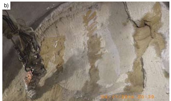
Rys. 10. Porównanie prognozowanego układu szczelin w płaszczu ochronnym tunelu z sytuacją rzeczywistą. Największe ryzyko stwarzały szczeliny w piaskach i żwirach, występujące poniżej poziomu wody gruntowej, a najmniejsze soczewki niezwiązanego gruntu, całkowicie otoczone materiałem Soilcrete i zlokalizowane powyżej poziomu wody gruntowej (a) przewidywany układ szczelin, (b) odsonięty przekrój tunelu i miejsca zawilgoceń
