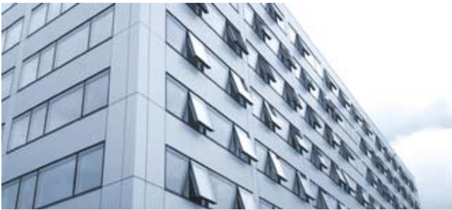
Fot. 3. Budynek Użyteczności Publicznej termomodernizowany
