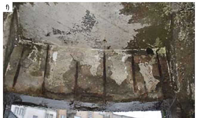
Rys. 4. Uszkodzenia elementów w obszarze podwórza kamienicy zlokalizowanej w Gdyni przy ulicy 3 Maja 27-31: a), b) zawilgocenie pomieszczeń garażu podziemnego poniżej podwórza, c), d), e), f) uszkodzenia żelbetowej altany
